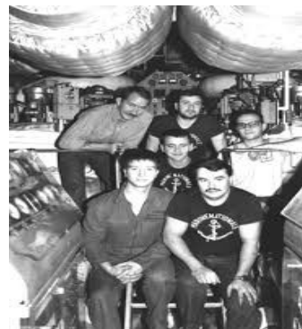
Une vue partielle entre les turbines à vapeur
