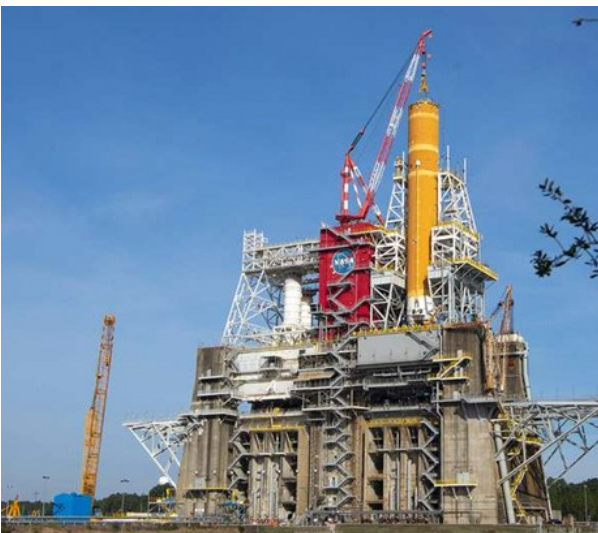
L'étage principal du SLS installé sur un banc de test du Centre Spatial Stennis de la Nasa en vue d'un essai "Green Run". © Nasa
