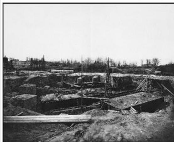
13 avril 1887 : construction des fondations de la tour Eiffel : Fonçage des caissons de la pile n° 4 (le caisson est visible à droite de l'image).
